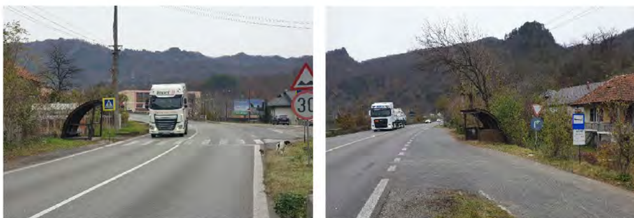
Figura 2.77. Infrastructură de acces Stația Lotru.
