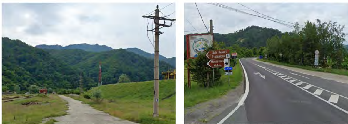
Figura 2.76. Infrastructură de acces Stația Lotru.
