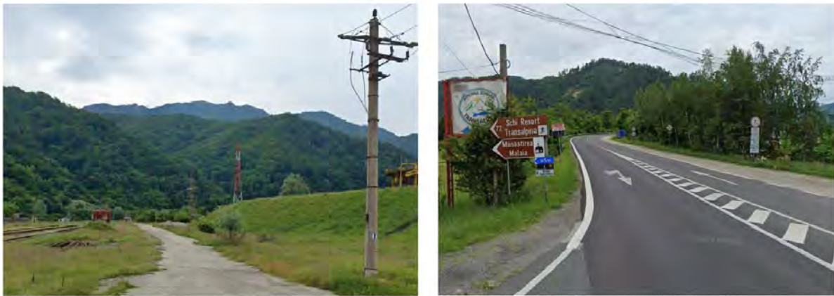
Figura 2.76. Infrastructură de acces Stația Lotru.
